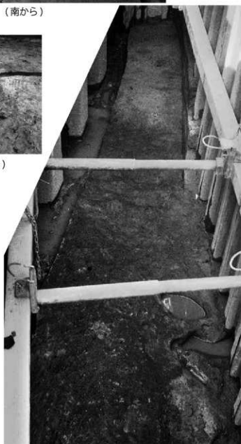
3. 08-1-3区 北端全景 (南西から)
