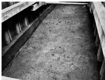
3. 08-1-3区 南端全景 (北西から)
