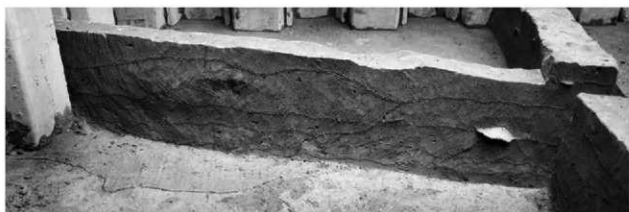
2. 08-1-2区 25建物南北断面（北から）
