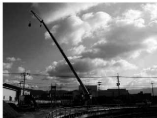
写真1 ラフタークレーンによる航空測量
