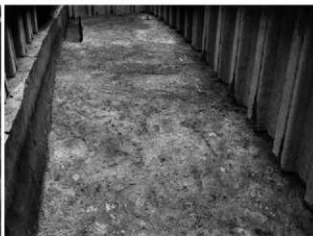
2. 08-1-3区 8流路(南端)検出状況 (西から)
