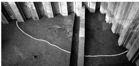
2. 08-1-2区 25建物(床2)近接(南から)
