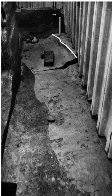
2. 08-1-3区 12溝近接（西から）
