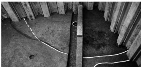
3. 08-1-2区 25建物(床3)近接(南から)
