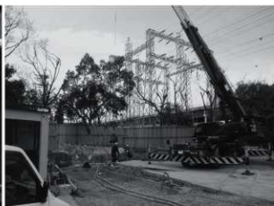
写真2 トラッククレーンによる撮影
