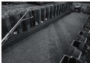
1 2区第3面遺構検出状況 (南東から)
