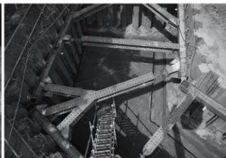
2 2区南端第9面(東から)
