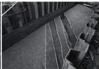
2 2区第3面遺構完掘状況 (南東から)
