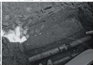
8 6-3区断面 (西から) 2
