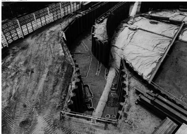
1. 2区 第4面 東半全景 (東から)
