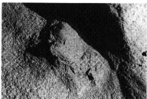
アスファルト塊 NW→
