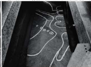
8 第12面全景(東から)
