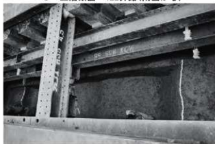
7 122井路全景(北東から)
