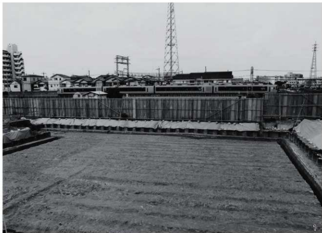
1 第3-1a面 1-2区 全景 (東から)
