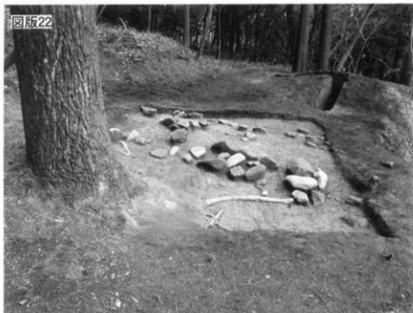
1. II区1~2トレンチ (東から)
