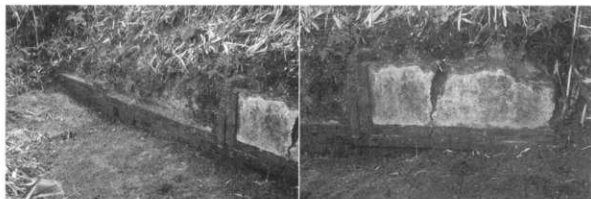
第7図 清水谷隧道の現況
