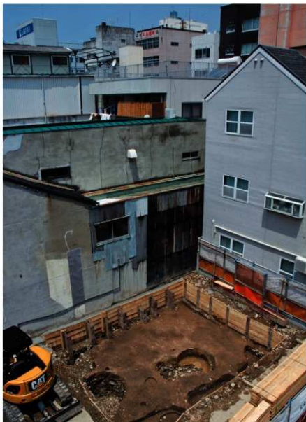
全景（南東から）
