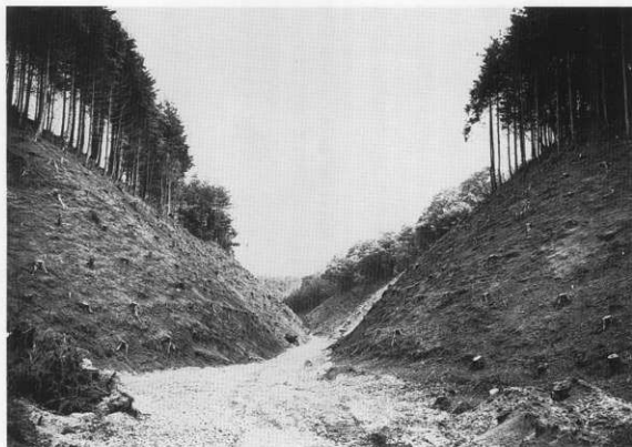
2. 伐採・防災工事後の状況 2
