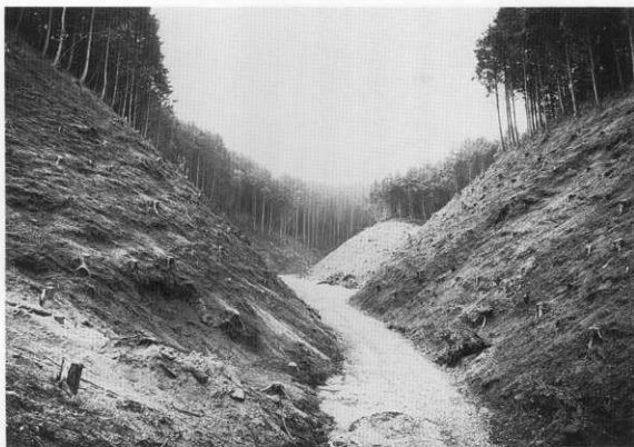
1. 伐採・防災工事後の状況 1
