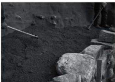
1 m ピッチに設置した排水層（粗粒マサ）
