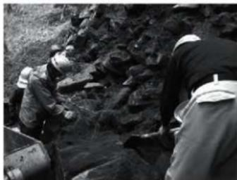
解体作業（石垣中の土砂と樹根の撤去）
