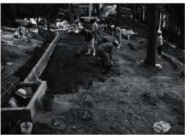
③排水工：排水施設の整備と保護盛土の施工
