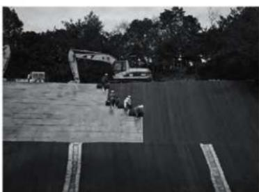
盛土表面の養生(浸食防止型養生マット)と土のう排水路
