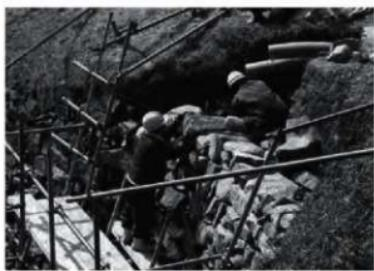
③石垣復旧工：石垣流出箇所の積み直し
