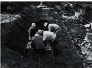
⑥河岸復旧工：フトンカゴの段積み
