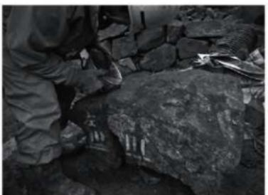
築石の補修状況（速乾セメント）
