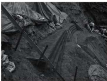
基礎の設置（改良土：柱穴掘方を避けて下方に設置）
