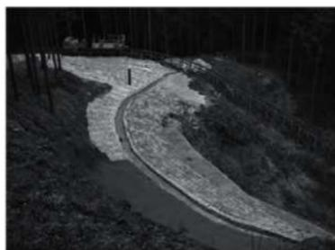
城壁上部のり面のり尻に設置した排水路
