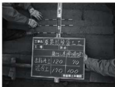
版築状盛土の試験施工（撒出厚と施工厚の関係）
