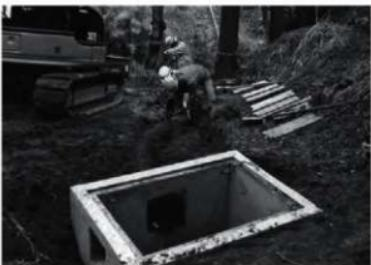
②排水工：集水樹(4-A)と排水管の埋設
