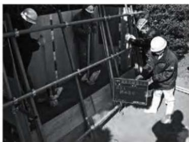
版築状盛土の試験施工（突固め状況）
