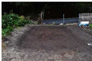
図47 第3地点1トレンチ埋め戻し完了状況(北東から) 原状に復した。
