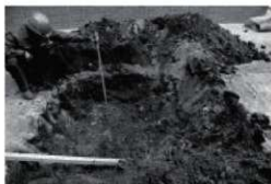
B. 事務局本館植栽復旧工事（北より）1701
