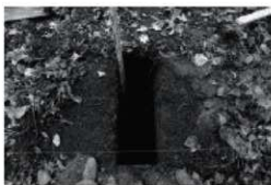
G. モデルパーキングフェンス改修工事 （西より）1711
