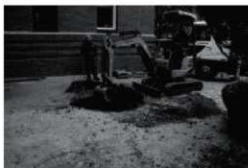
A. 事務局本館植栽復旧工事（西より）1701
