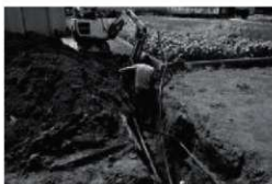
E. 農学部園場給水管更新工事（南より）1708
