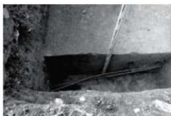
D. TP09 西壁 (東より)
