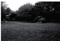
A. 調査区遠景 (南東より)
