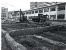
B. 表土はぎの様子(遠景:南東より)
