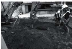
A. 情報基盤センター北側冷却棟設置工事 (西より) 1807
