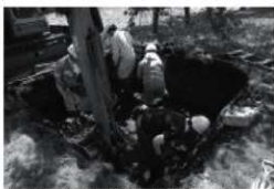
A. 調査の様子1 (TP02:北東より) 1806
