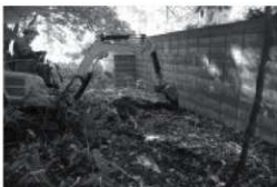
C. 植物園腐葉土置場ブロック塀補強工事 (北より) 1815
