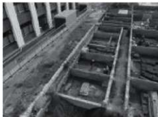
C. 調査の様子(遠景:東より)
