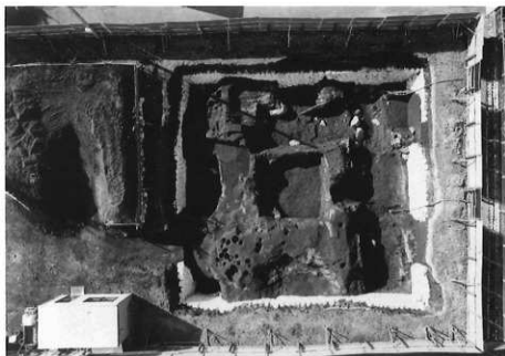
2. 調査区北側（完掘）
