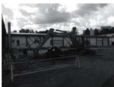
B. 掘削の様子(遠景:南東より)
