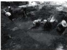
D. 課外活動施設車庫新営工事(南東より)1907
