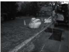
F. 学修支援施設(百年記念館)改修機械設備工事(南東より)1912
