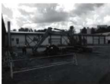
B. 掘削の様子(遠景:南東より)
