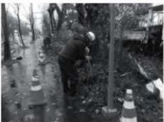
G. 北23条1号棟フェンス改修工事(西より)1913
