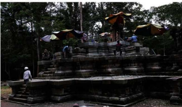
第25図 中央祠堂基壇再構築作業風景
