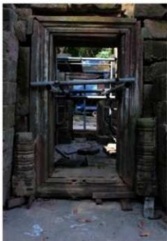
Fig.6 東面屏枠（仮組中）
