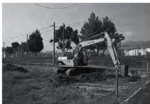
重機による表土掘削状況
