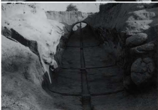
2 7号窯跡石組み構築・一次操業面 断ち割り状況（北西から）
