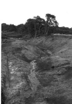
2 河道部完掘（南から）
