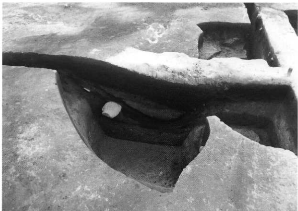
2 P-3セクション（北から）
