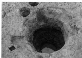
S E 3011 全 景
