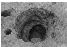
S E 3012 全 景
