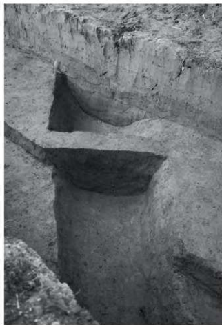
1 I区 SD30 掘削状況 北東から
