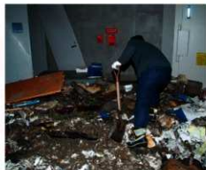
石巻文化センター 取壊前付近の状況
