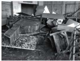
石巻市立門脇小学校1階 民俗資料の展示室の被災状況 (2011年4月29日 岡田健撮影)
