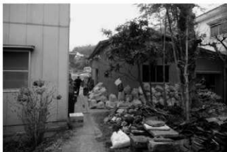
図2 作業日の敷地内
