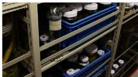
落下対策として突っ張り棒を設置している棚
