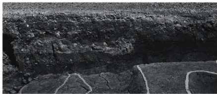
1. 1区北壁東側 断面 (南から)
