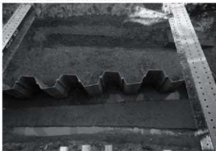
5 3区第2層除去面と北壁断面(南から)
