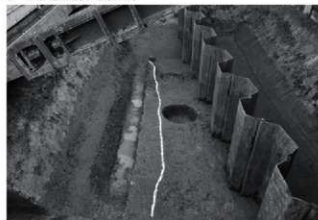
4 3区第2層除去面(西から)
