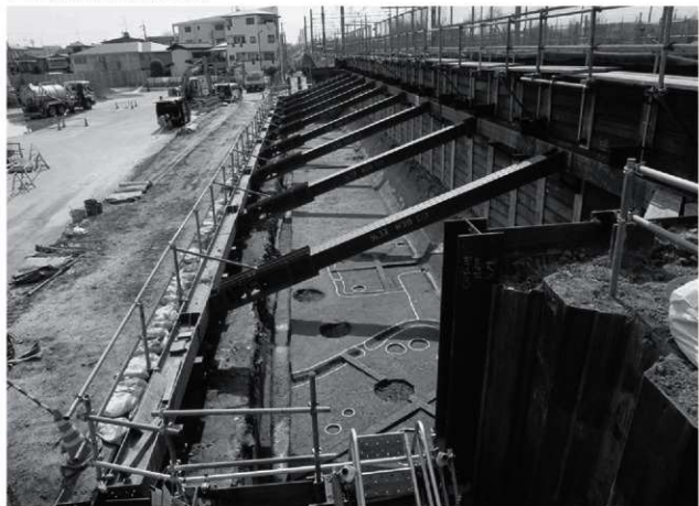
2 4区第4层除去面全景(東から)
