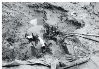
石垣掘り出し作業
