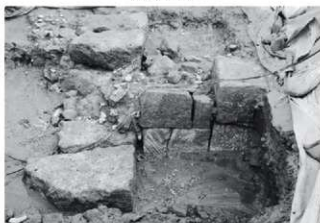
石垣と栗石の完掘状況
