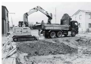
造成土の掘取りと搬出状況
