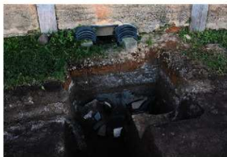
4. 42-9トレンチ暗渠と復元暗渠(北から)
