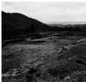
4 調査終了(南西から)
