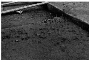
3 M22区(南東から)
