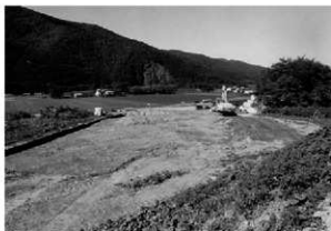
5 重機調査区調査終了 (南から)
