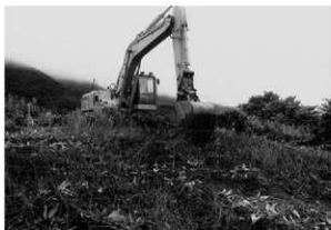
1 笹根除去・伐根状況 (北東から)
