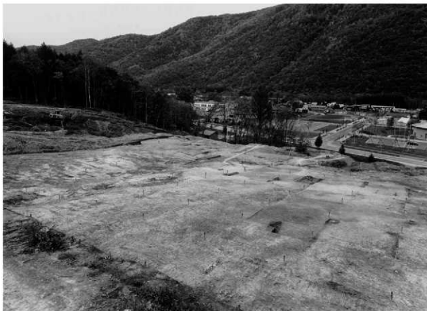
1 44ライン以西調査終了 (南東から)
