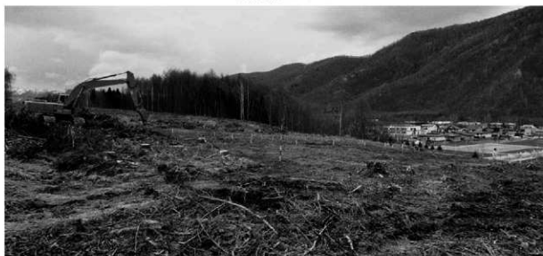
2 表土除去・杭打ち (南東から)
