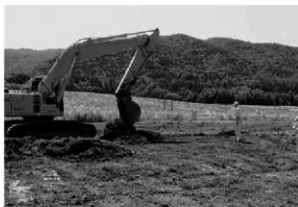
2 表土除去 (北から)
