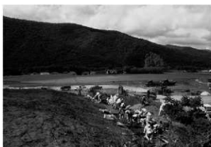
3 斜面部調査 (南から)
