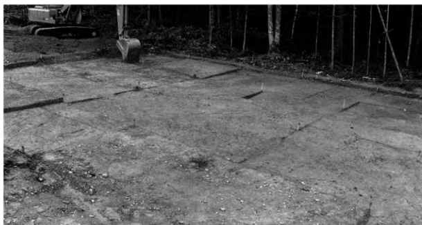
3 18ライン以西調査終了 (南東から)
