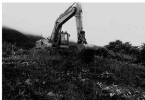
1 笹根除去・伐根状況 (北東から)
