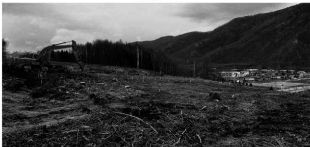
2 表土除去・杭打ち (南東から)
