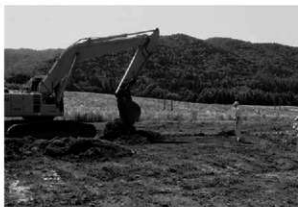
2 表土除去 (北から)
