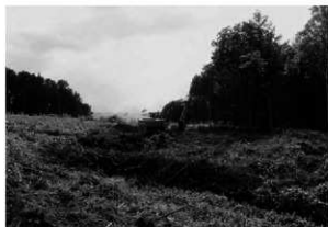
1 菅根除去・伐根状況 (東から)
