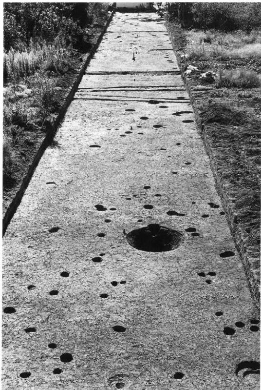
2次 O-14~22区全景 (北から)
