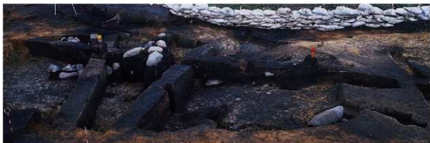
H-2・P-68 セクション (南西から)
