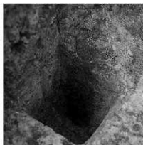
H-3HP-1セクション (南から)
