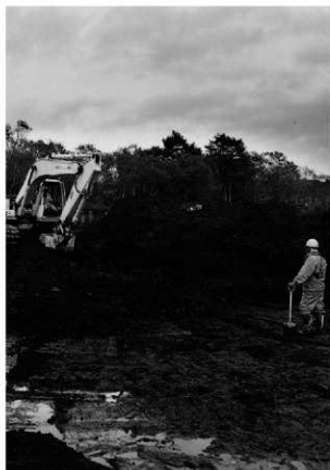
2 X層調査状況 (北西から)
