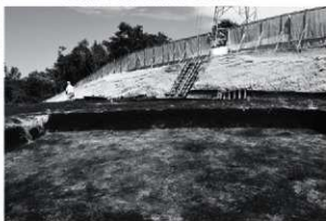
5 39ライン 土層断面 NW→
