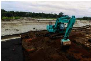
1. Ta-d層 除去作業（南東から）
