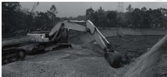
1. 表土・Ta-b層 除去作業（北西から）
