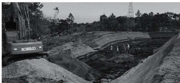
2. 表土・Ta-b層 除去作業および測量業務（北西から）
