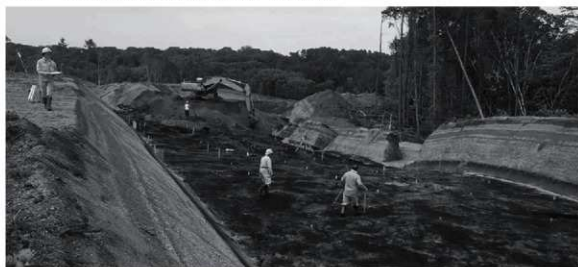
3. 表土・Ta-b層 除去作業および測量業務（南から）
