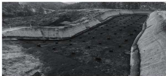
6. II B層 完掘 (北西から)
