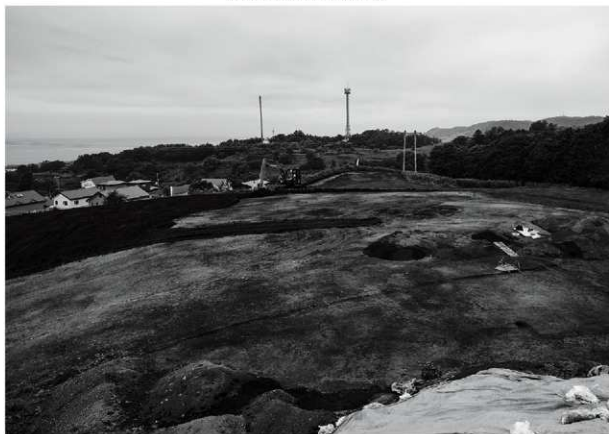
調査区西側埋め戻し作業(東から)
