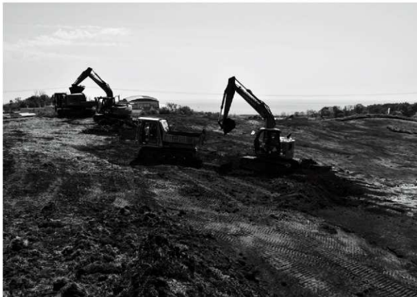
調査区中央表土除去作業(北東から)
