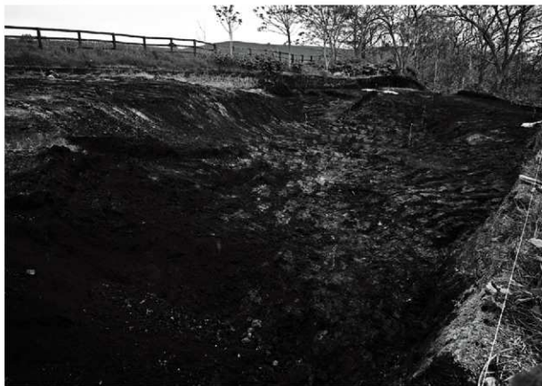
沢部埋め土除去完了(北西から)
