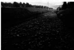
8 調査区西部礎層検出 (西から)
