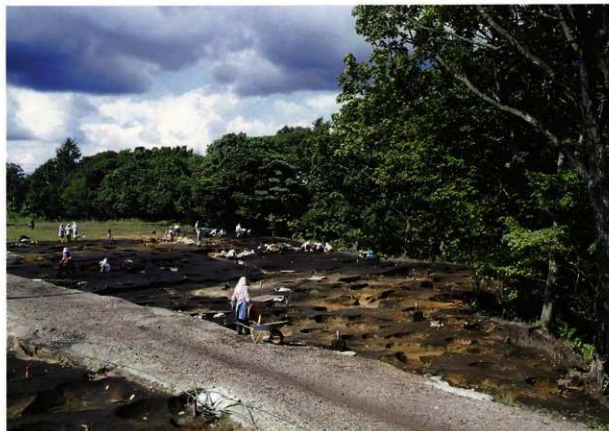
調査状況 (2006. 9. 1、j-85 付近から) E→
