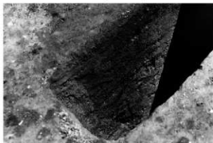
3 HP- 2セクション(西から)
