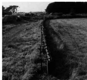
ウエル・ポイント吸水管・集水管
