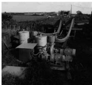
ウエル・ポイントメインポンプ
