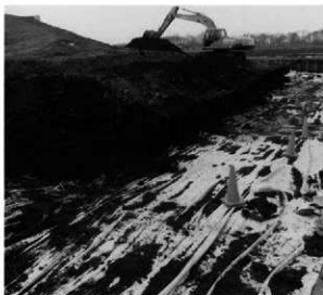
保護用シート設置状況
