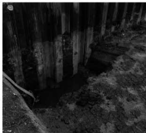
カマ場設置状況
