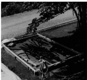
大型木製品用屋外プール設置状況
