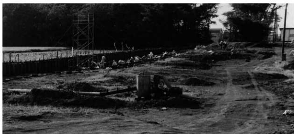
ウエル・ポイント設置状況
