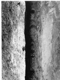
15. TP7杭痕検出 (NW→SE)
