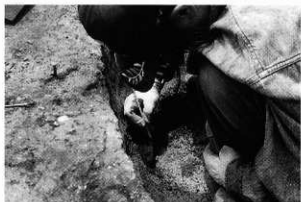
151. P68作業風景 (NW→SE)
