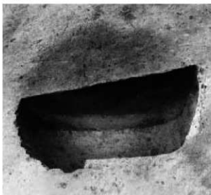
1 P-1セクション (北から)
