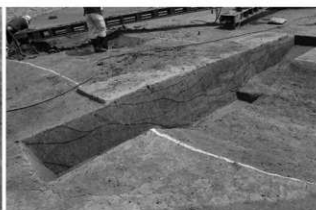
49、1 トレンチ 188 流路断面 (南西から)
