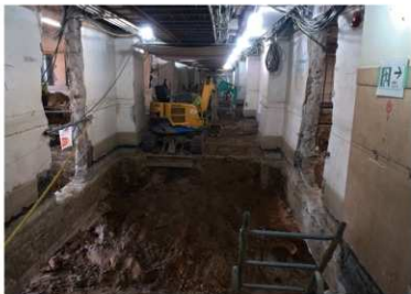
写真7 北-2工区 1次・2次掘削状況
