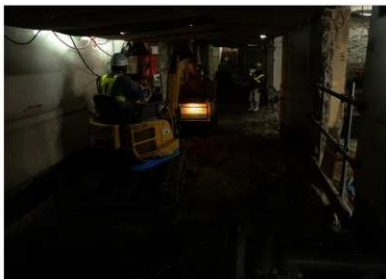
写真1 1次・2次掘削状況（南-2工区）
