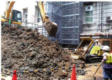
写真12 中ー2区 1次・2次掘削土砂集積状況
