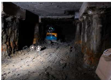
写真3 3次・4次掘削状況（北-2工区）
