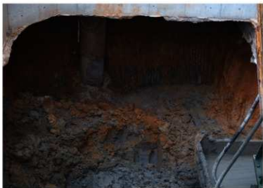
写真10 北-2工区 3次・4次掘削土層断面
