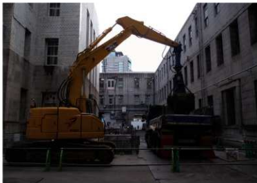
写真13 中-1工区 3次・4次掘削土搬出状況
