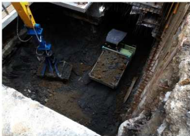
写真14 中-1工区 3次・4次掘削搬出口
