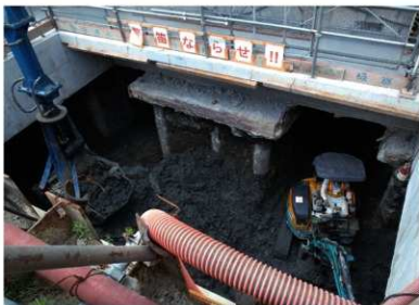
写真4 3次・4次掘削搬出口（南-2工区）
