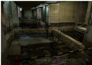
写真11 中ー2区 1次・2次掘削状況
