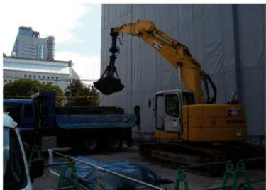
写真18 南-2工区 3次・4次掘削土搬出状況
