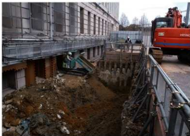
写真16 南-1工区 1次・2次掘削土搬出状況
