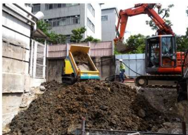
写真2 1次・2次掘削土集積状況（北工区）
