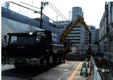
写真17 南-1工区 3次・4次掘削土搬出状況
