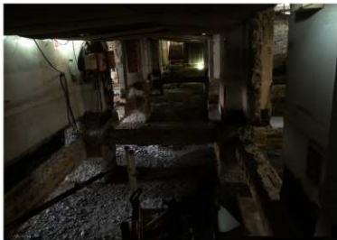
写真15 南-2工区 1次・2次掘削状況
