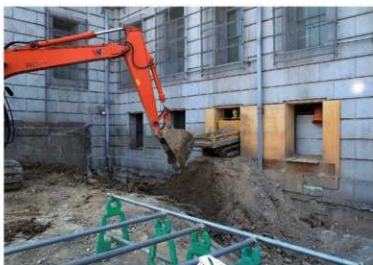
写真8 北-2工区 1次・2次掘削土搬出状況
