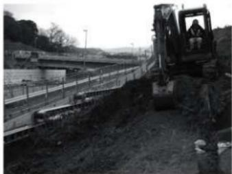
写真2 表土層掘削状況
